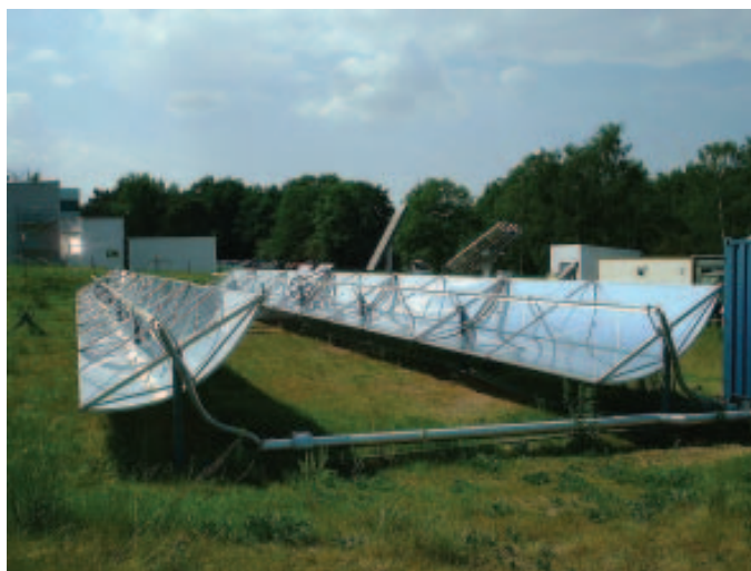
Dampfstrahlkälte und Parabolrinnenkollektoren zur innovativen Kälteerzeugung (Quelle: DLR Köln-Wahn)
