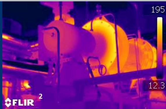
1 Verdampfer ORC-Prozess mit Abgaswärmezufuhr aus einem Gasmotor.
